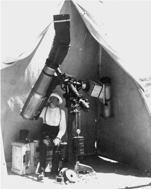
Bild 4. Emden im Beobachtungzelt in Guelma am Sonnenteleskop mit dem aufgesetzten Objektivprisma zur Aufnahme von Flash- und Coronaspektren während der Sonnenfinsternis von 1905. Quelle: Deutsches Museum München, Archiv.
